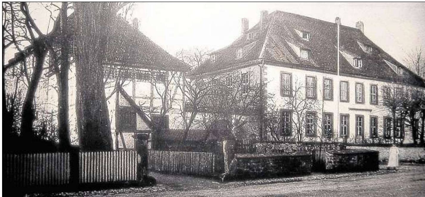
Historische Aufnahme aus den 1930er Jahren: Im heutigen Moringer Rathaus (rechts) befand sich von 1852 bis 1973 das Amtsgericht. Verurteilte Straftäter saßen ihre Strafe gleich nebenan im heutigen Bauamt ab. Foto: nh
