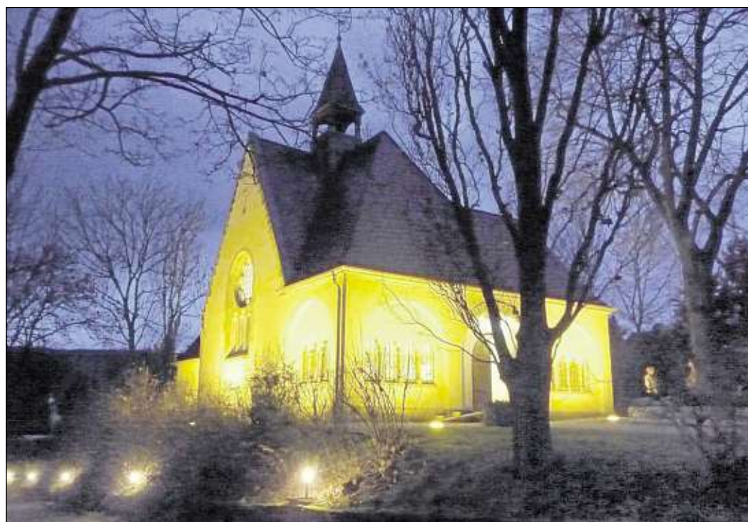
Vielfältig genutzt: Die Kapelle Am Stockweg wurde in den letzten 15 Jahren umfassend saniert. Die Erfolgsgeschichte der Sanierung zeigt eine Ausstellung vom 22. bis 24. Februar. Foto: Horst Mandl/Repro: zkr
