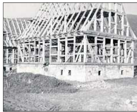
Baubeginn 1937: Die Siedlung in Hemeln, jetzt Bürgermeister-Wallbach-Straße, entsteht. Fotos: privat/Repro: Siebert
