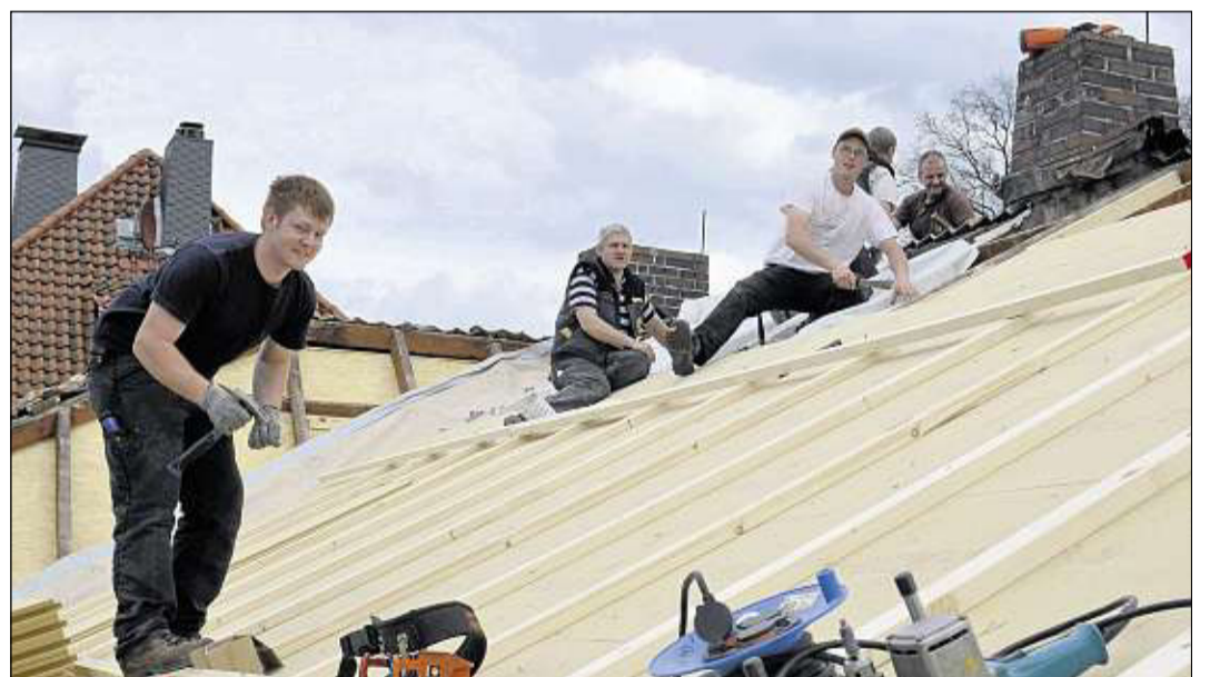
Auftrag unter blauem Himmel: Die Zimmerleute auf einer Baustelle in der „Schönen Aussicht“.
