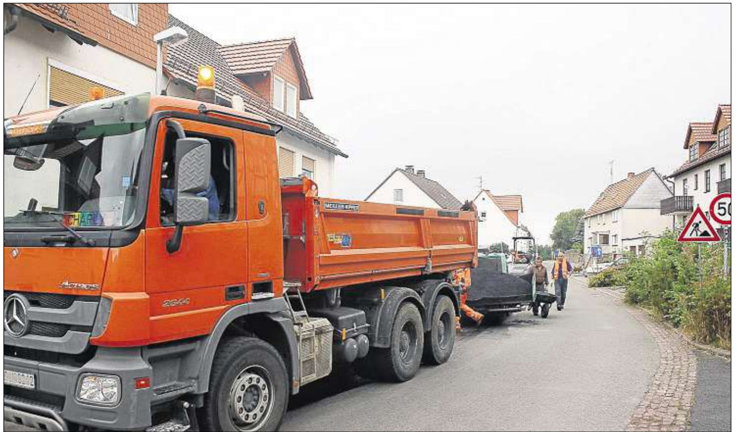
Baumaschinen unterwegs: Auf der Falkensteinstraße in Elmshagen wurde in den vergangenen Tagen kräftig gearbeitet. Teile des Randbereiches wurden ausgebessert.
