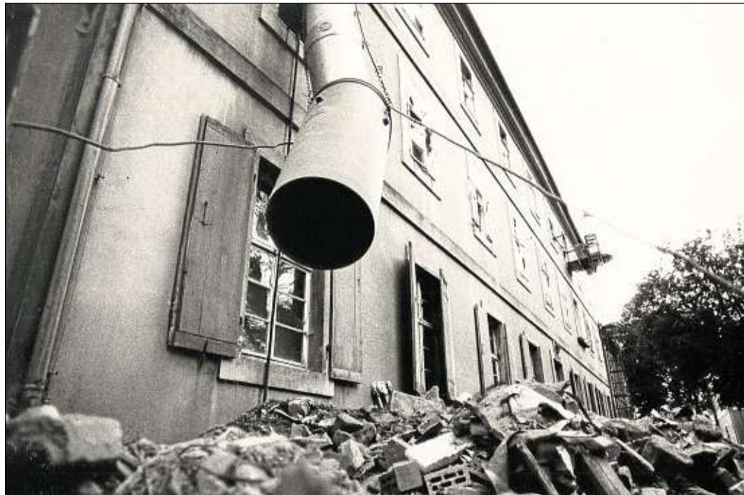
Hofgeismar, Beberbeck 1991/92: Die ehemaligen Wohngebäude (hier Beamtenhaus) werden saniert, um ab 1992 etwa zehn Jahre lang als Unterkunft für Aus- und Übersiedler zu dienen.
