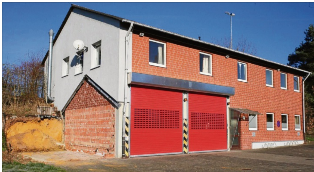
Anbau geplant: Platz dafür wurde am Feuerwehrgerätehaus Scheden bereits geschaffen, eine kleine Garage wurde abgerissen.
